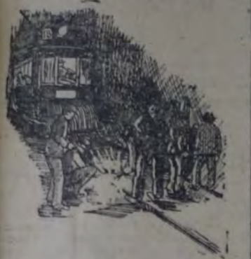
Una cuadrilla de vía permanente haciendo una reparación
